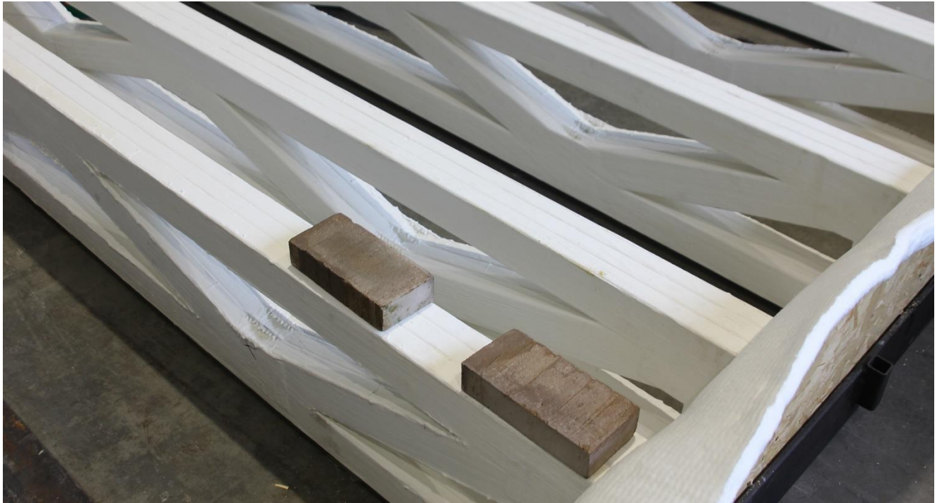
Figur 8 Teglstein ble løst plassert oppå takstolene før Leca Byggeplank ble løftet på.
