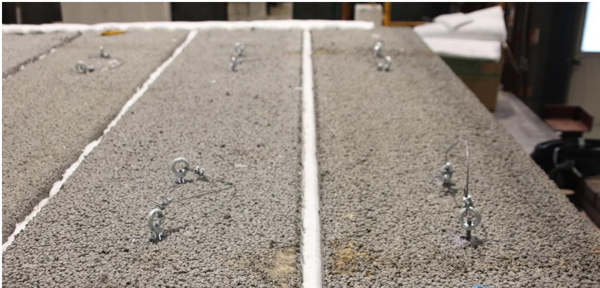
Figur 9 Leca Byggeplank ble løftet og lagt ned på teglsteinene på takstolene med AES-fiberisolasjon mellom hver Leca Byggeplank. Hempene er laget av stålvaier og Leca anker, og ble brukt til å løfte av/på.
